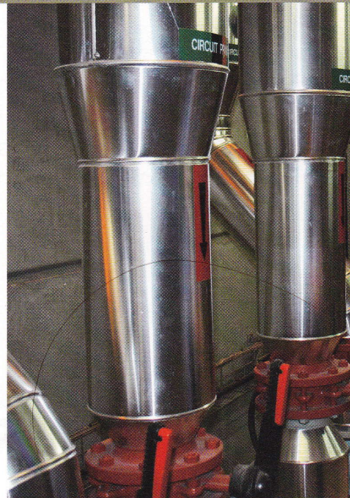
Relevé à la chaufferie bois d'Haguenau (67).
