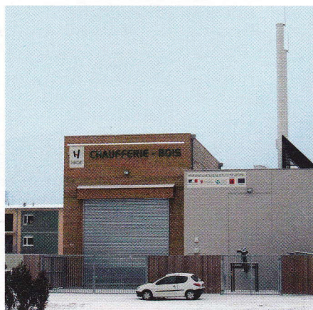
La chaufferie bois d'Héricourt (70).
