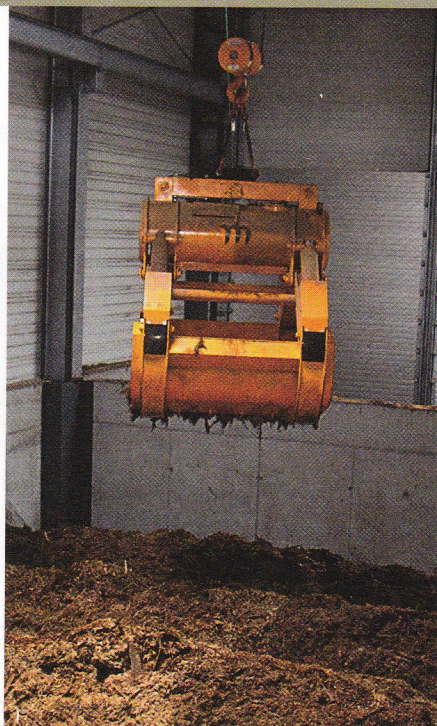
Alimentation de la chaufferie bois de l'OPAC de l'Indre (36).
